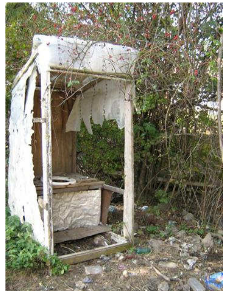
Het bewuste buitenhuis toilet
