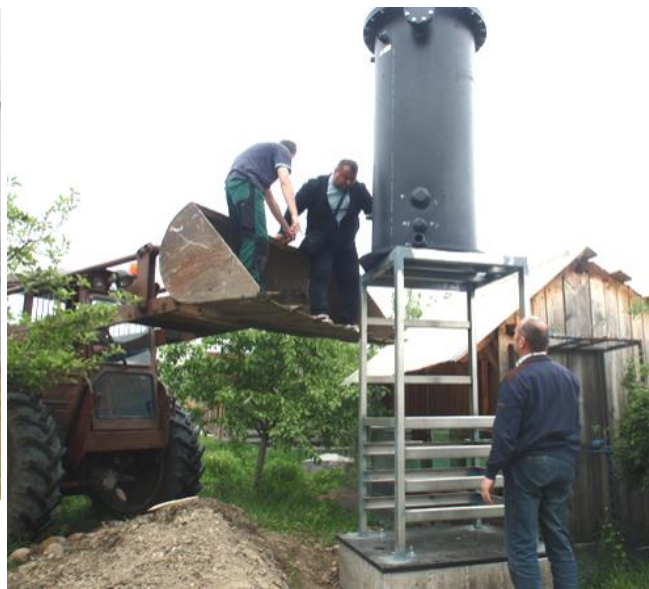
Op de betonnen sokkel komt een frame met daarop een watertank van 1.300 liter voor de groentekas.
