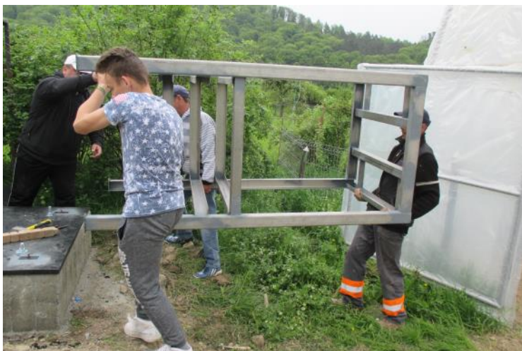
Op de betonnen sokkel komt een frame met daarop een watertank van 1.300 liter voor de groentekas.
