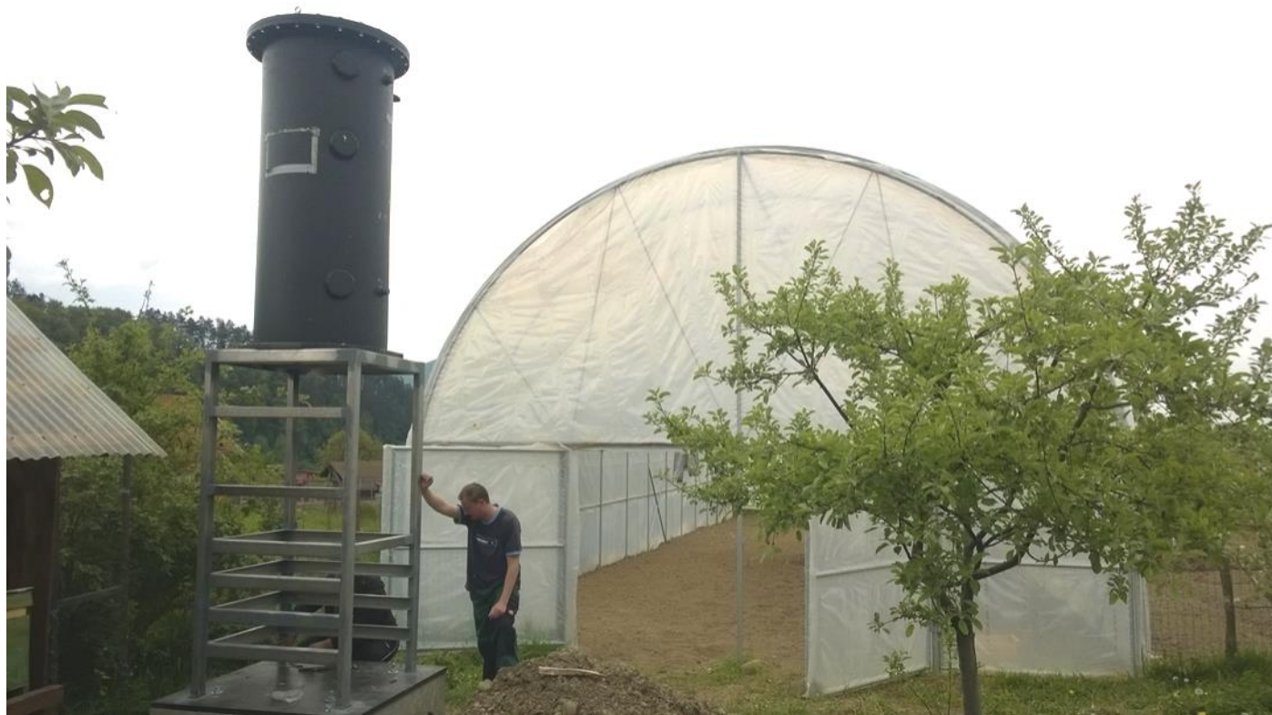
Op de betonnen sokkel komt een frame met daarop een watertank van 1.300 liter voor de groentekas.
